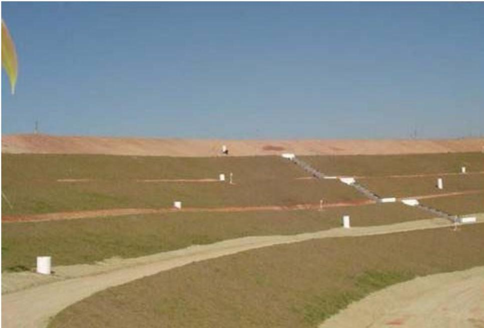
**Figura 33 - Detalhe ilustrativo Canaletas, Bermas, Descida de Água no Talude e Proteção Superficial com Grama.**
