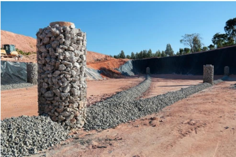
**Figura 32 - Detalhe ilustrativo da drenagem de percolado (horizontal) e drenagem de gases (vertical) interconectados.**
